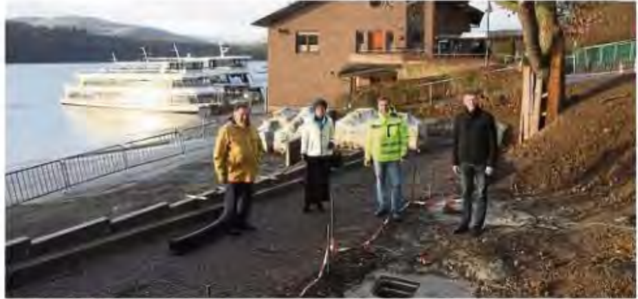
Stellten die Pläne vor: Von rechts Bürgermeister Jürgen Vollbracht, Bauamtsmitarbeiter Sebastian Boos, Lisa Küpper vom Kellerwaldverein und Schifffahrtsunternehmer Wilfried Meyer; im Bild zu sehen sind die Betonanker für einen überdachten Platz.
